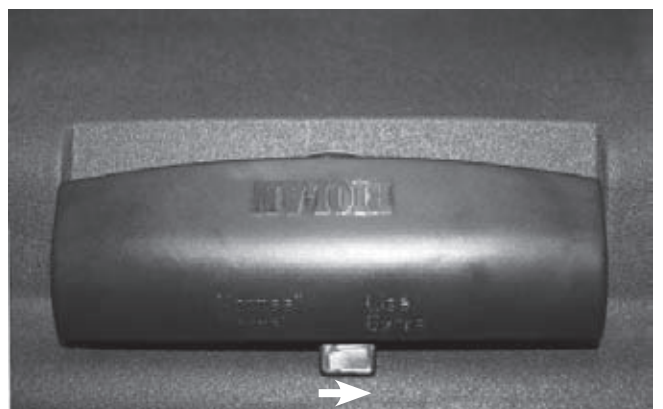
Kuva 5. Poistoilmaventtiili lisä/extra-asennossa
