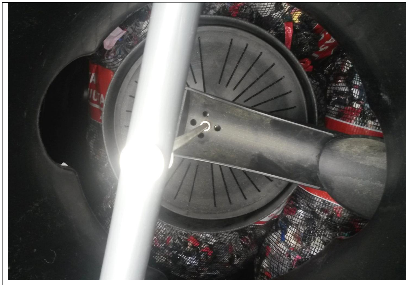
Kuva 7. Jakoaltaan kourun asentaminen tuloviemärin alle.
