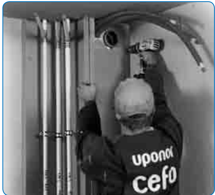
Kuva 39. Elementtien asennus käy helposti ja nopeasti, asunnossa on mahdollisuus asua remontin ajan lyhyen asennusajan johdosta.
