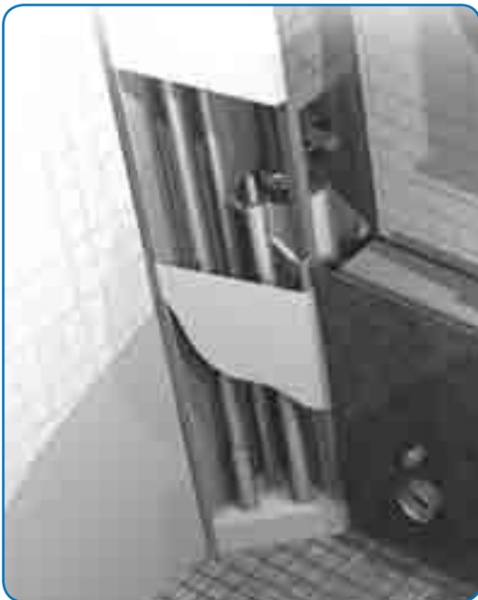
Kuva 38. Elementtien vuodonilmaisimet tuovat vuotoveden näkyviin.
