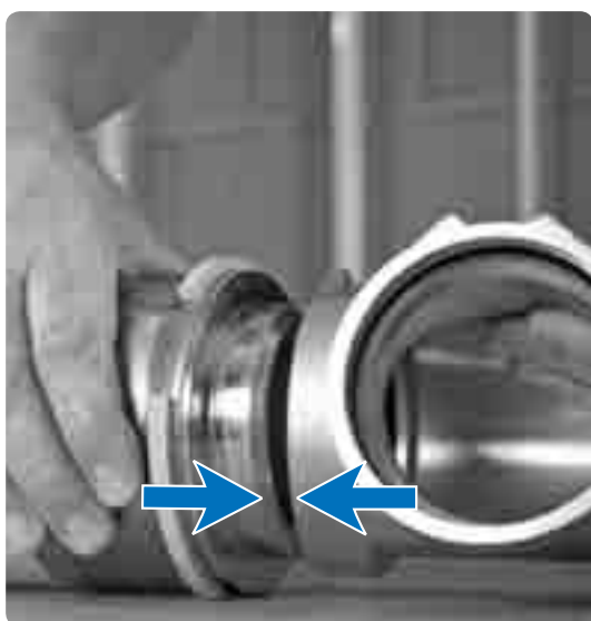
Kuva 3. Asenna putkeen liitetty puristusliitin perusosaan.
